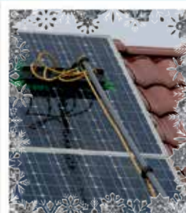
Photovoltaikreinigung
